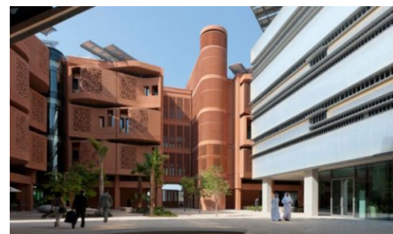
Une tour à vent avale le vent chaud par son sommet et renvoie de l'air frais par sa base
